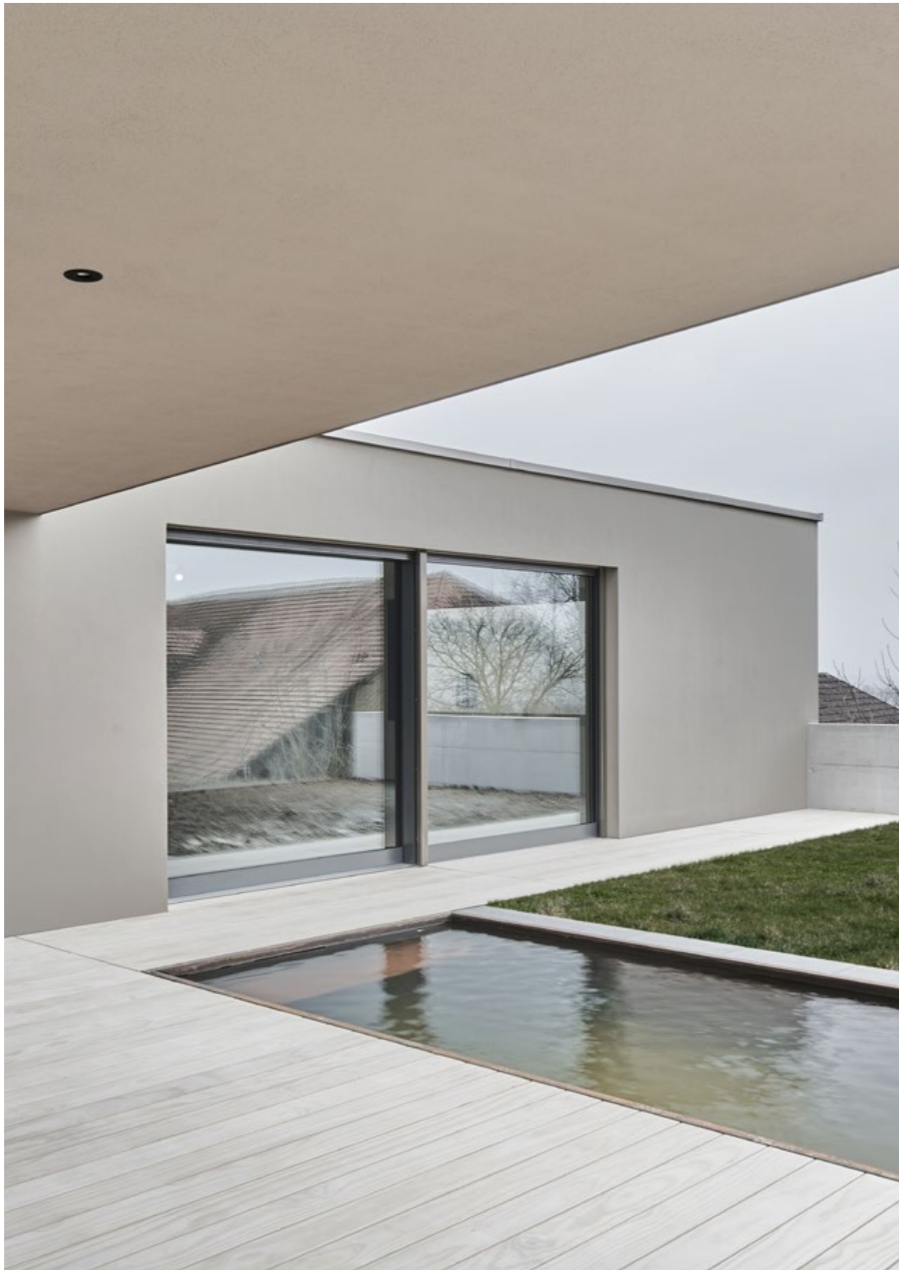
gedeckter loggiabereich mit blick zu pool aus rohem stahl
