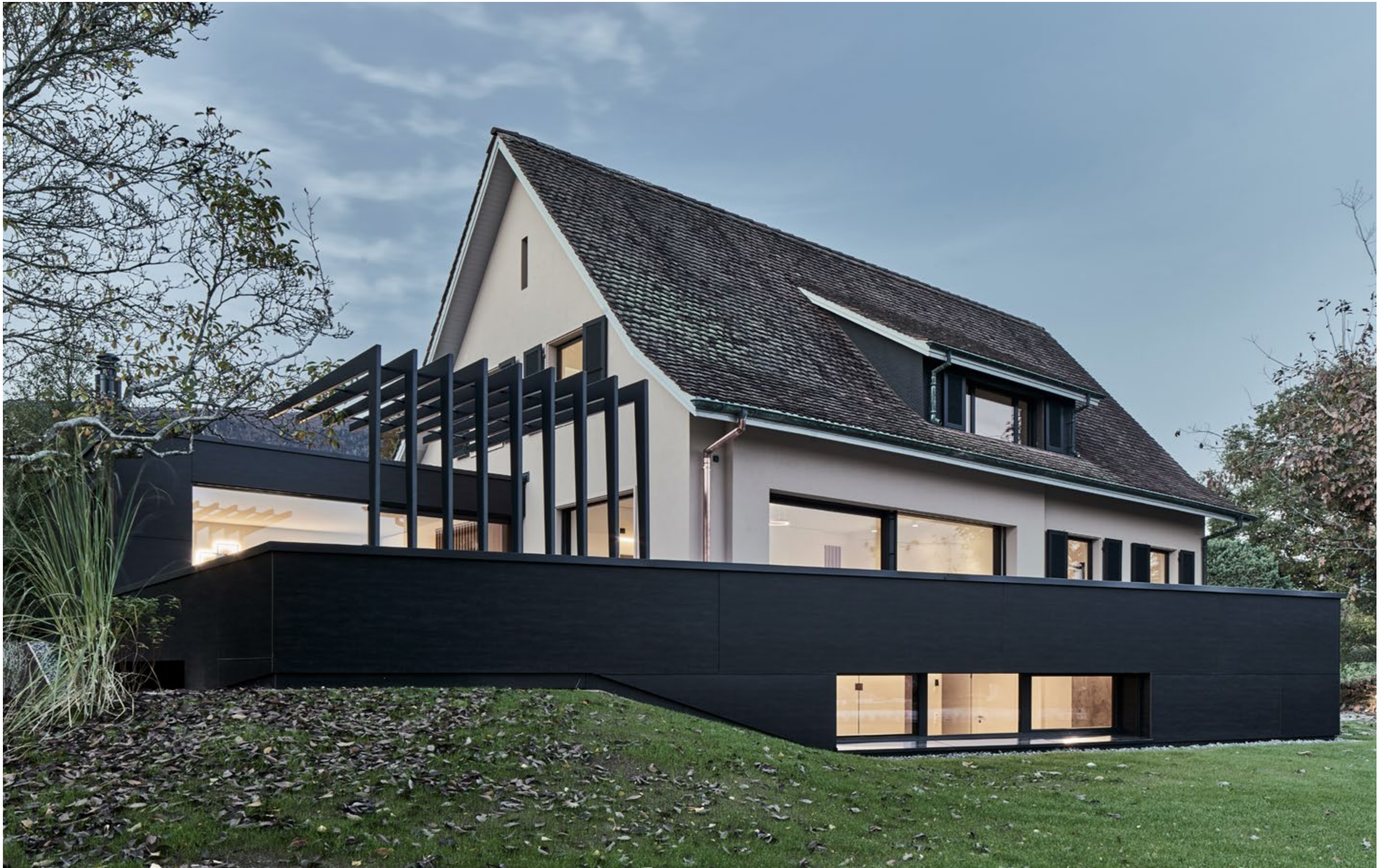
pavillonanbau mit sitzplatz und freischwebender stahl - lamellen - pergola
