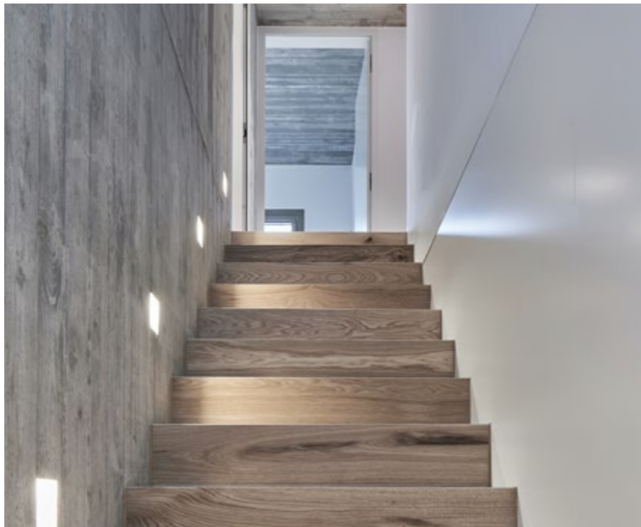
treppenläufer aus eichenparkett mit led - einbauleuchten in sichtbetonwand mit bretterstruktur
