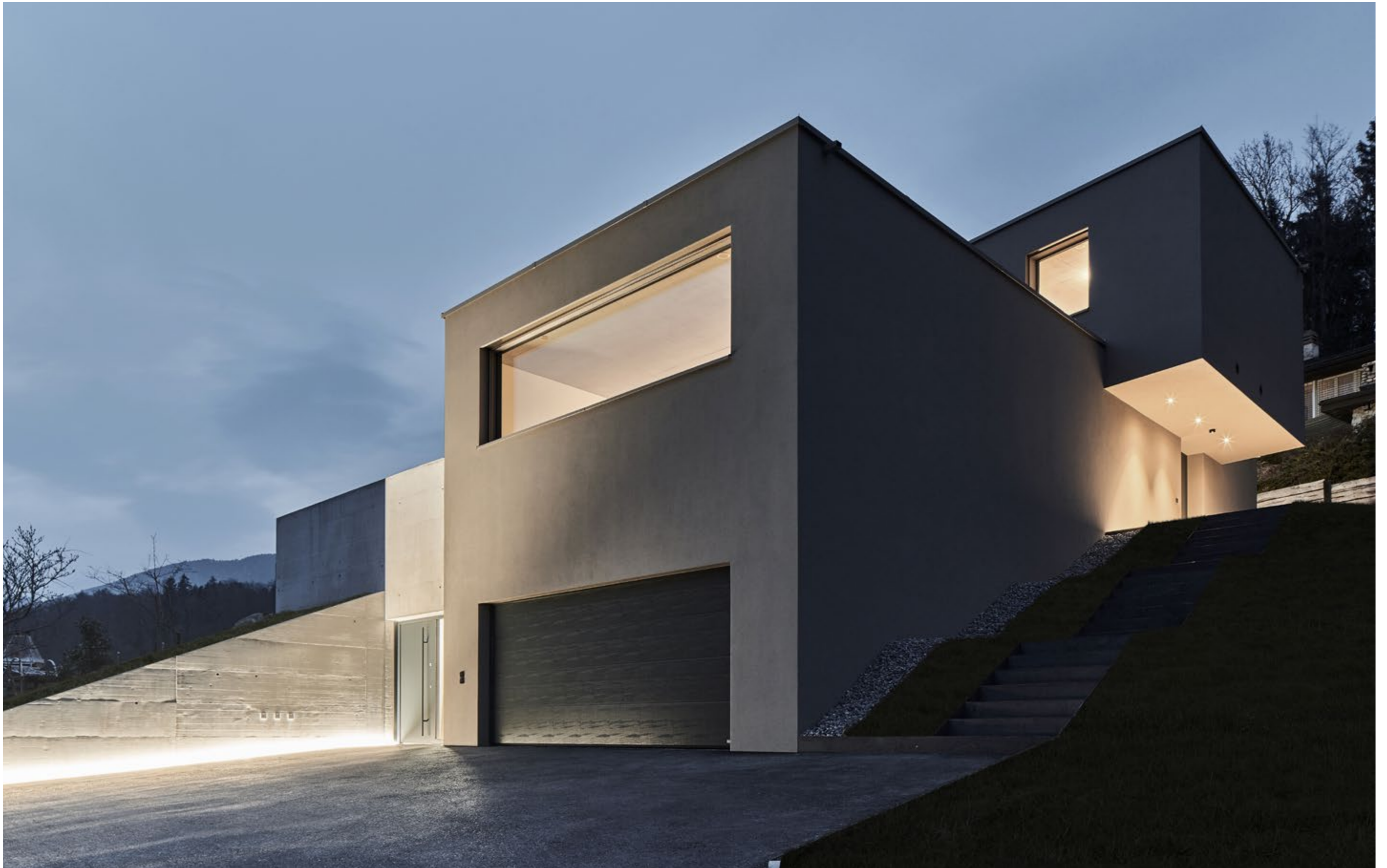
südfassade mit doppelgarage und aussentreppe in rohem stahl zu eingangsbereich
