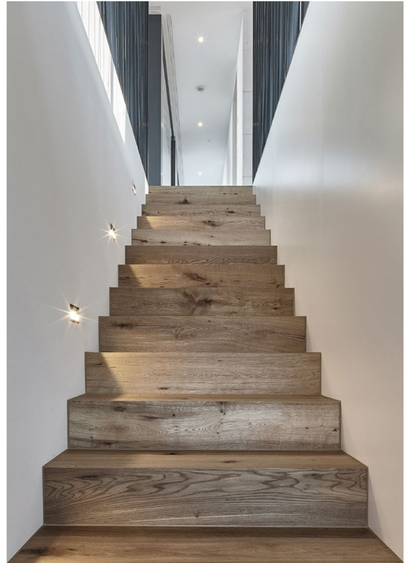
treppenläufer aus eichenparkett mit led - einbauleuchten aus edelstahl
