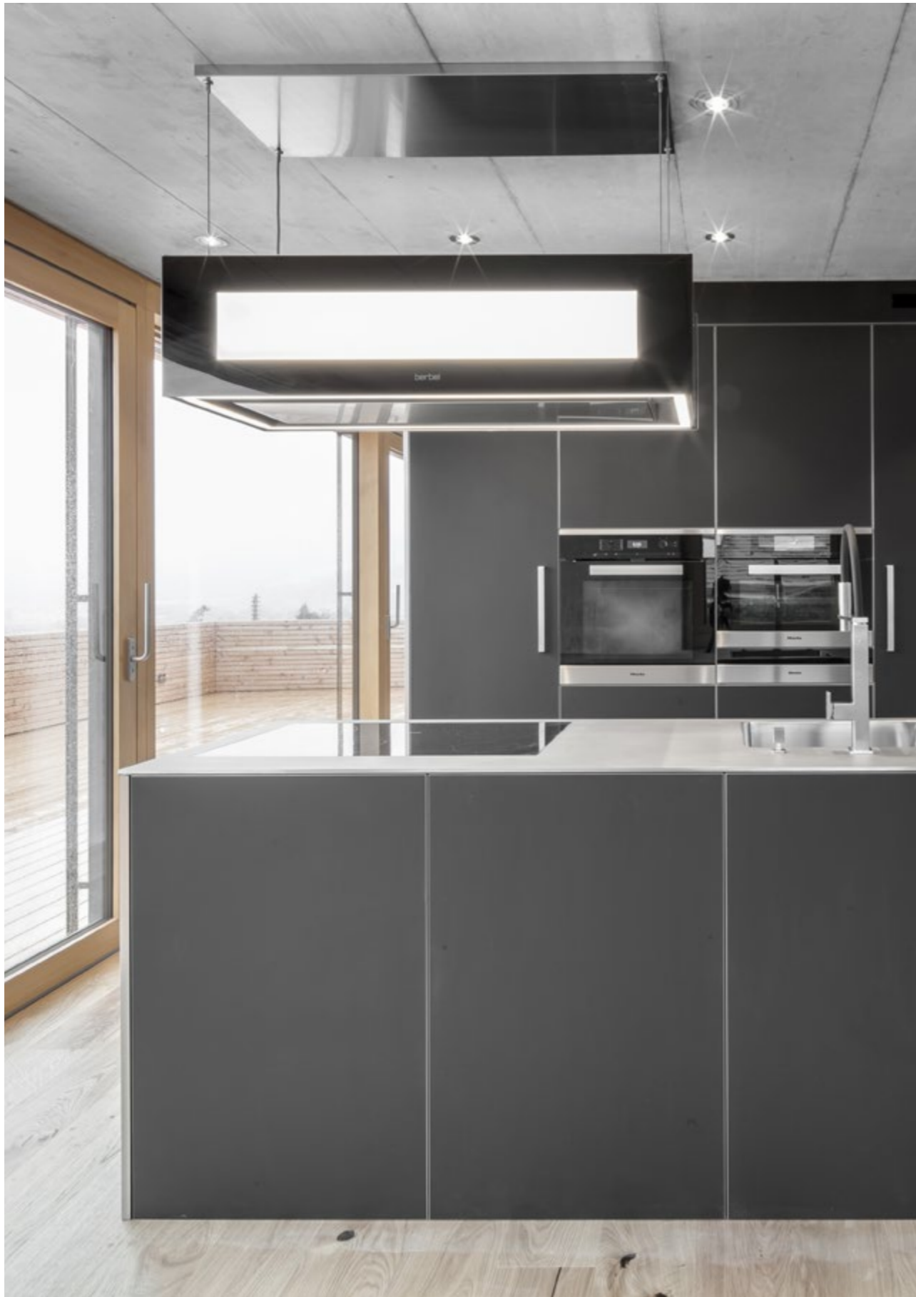
kochinsel mit umluftabzug auf sichtbetondecke mit tafelstruktur
