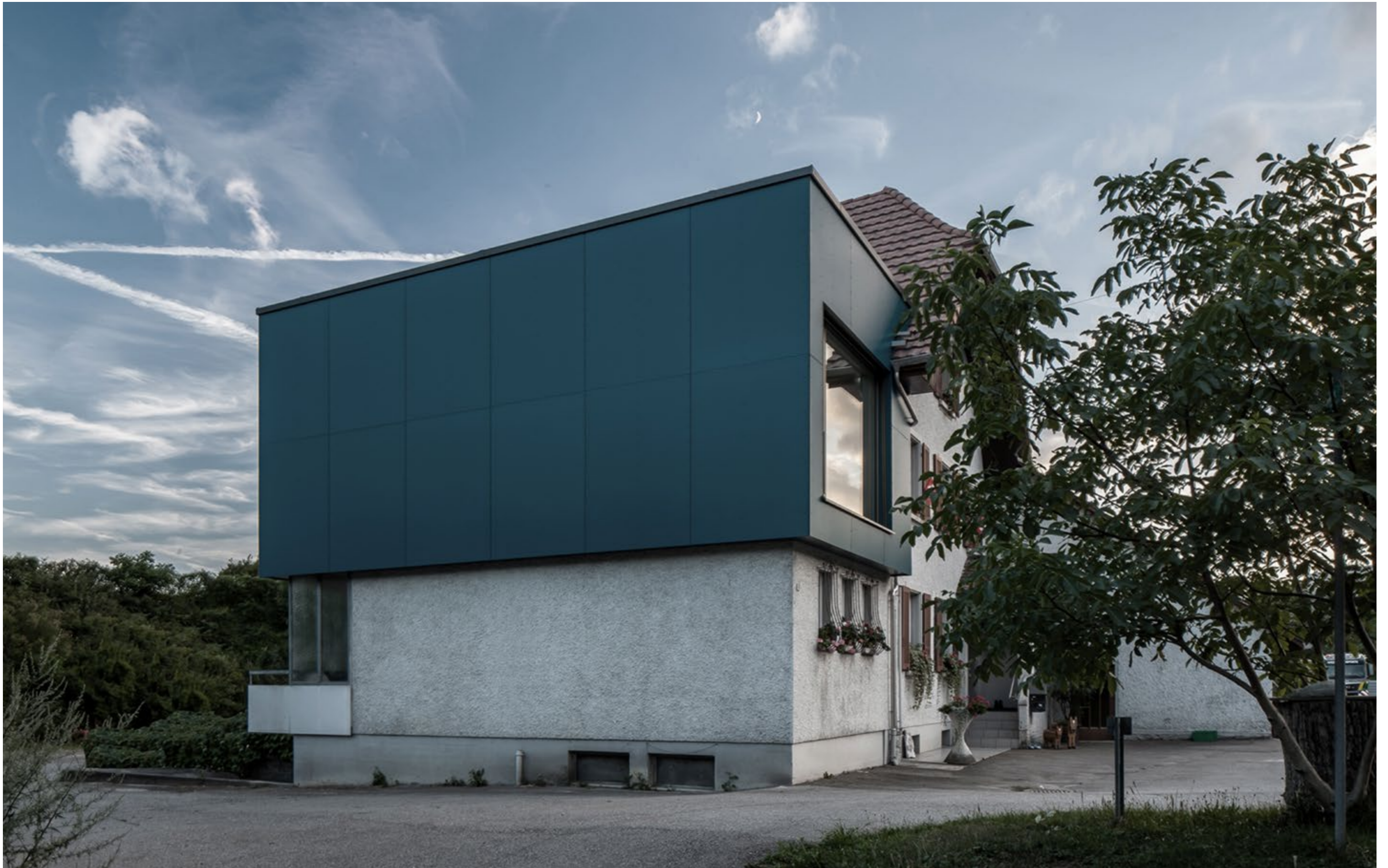
nord- und ostfassade mit raumhoher und raumbreiter fensterverglasung
