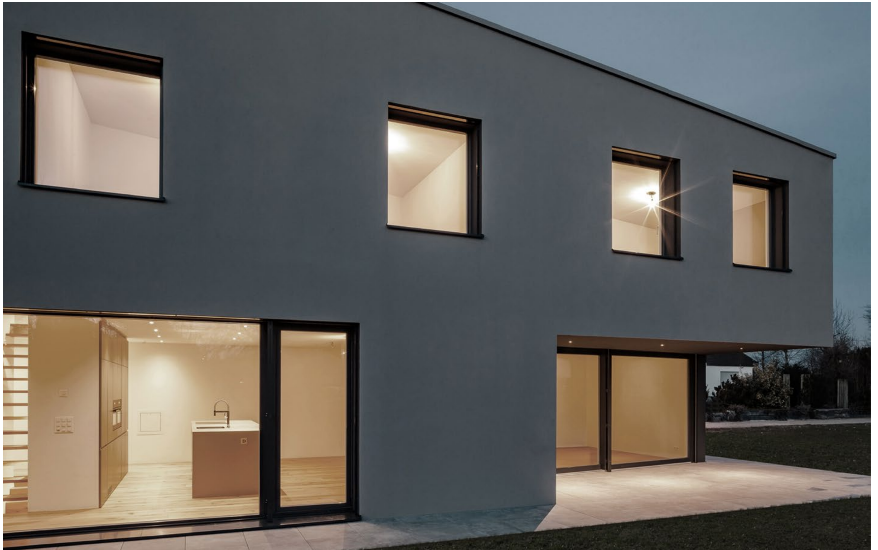
südfassade mit blick zum koch- und essbereich und anschliessendem wohnbereich mit gedeckter loggia
