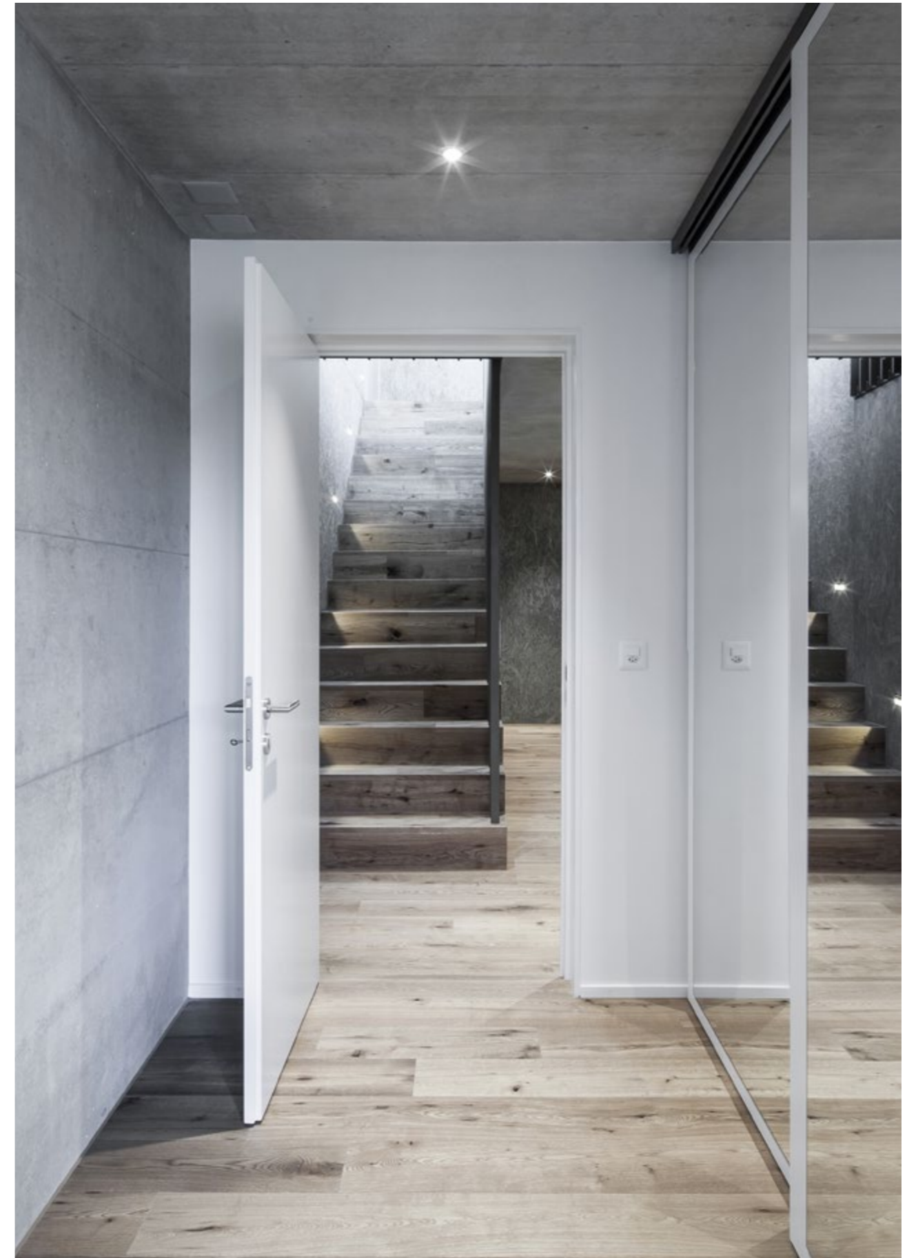
begehbare ankleide aus sichtbeton mit tafelstruktur und blick zur wohnungsinternen treppe
