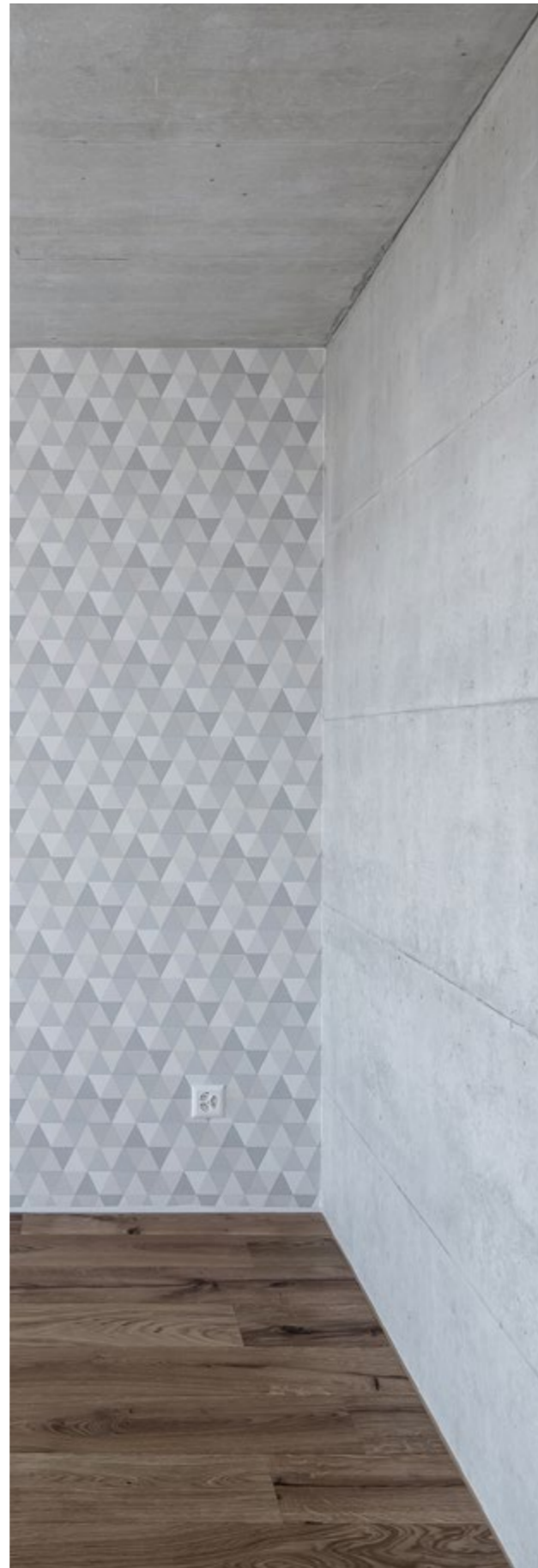
decke und wand aus sichtbeton mit tafelstruktur
