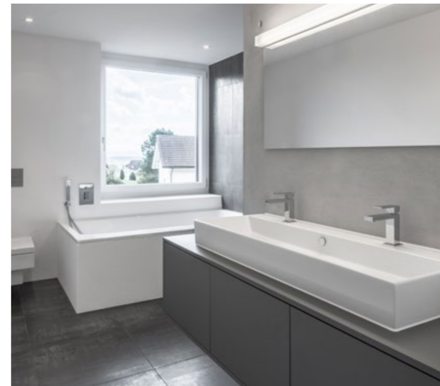
sichtbetonwand mit schalungsstruktur und unterbaumöbel mit keramikwaschtisch
