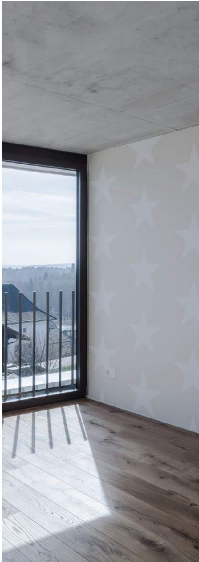
holzmetallfenster mit absturzsicherung aus pulverbeschichteten rundstahlstäben
