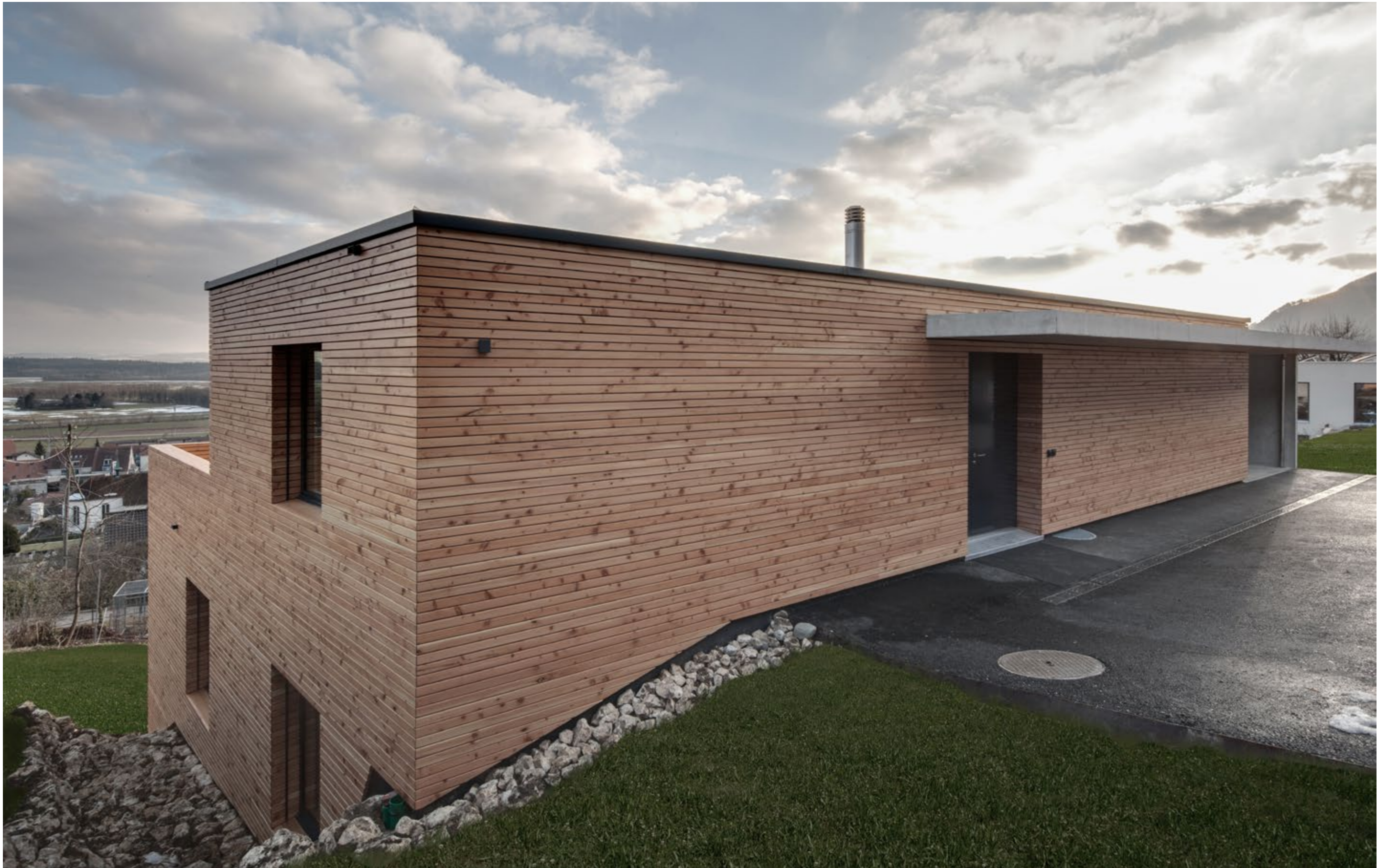
nord- und südfassade mit patio aus jurakalksteinen und gedecktem zugangsbereich aus sichtbeton mit tafelstruktur
