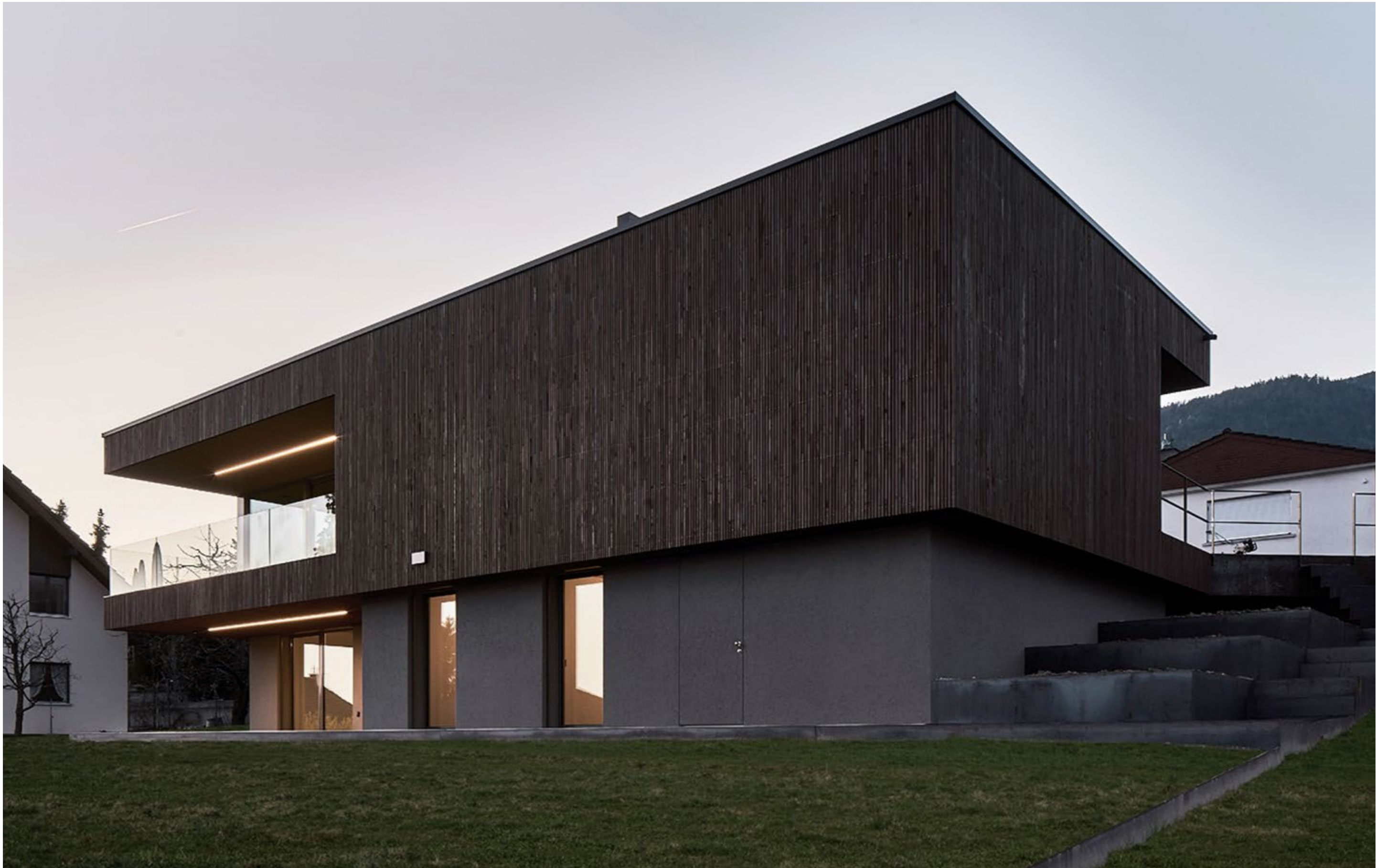
südoostfassade mit gedeckten loggiabereichen und umgebungsabtreppungen mit rohem stahl
