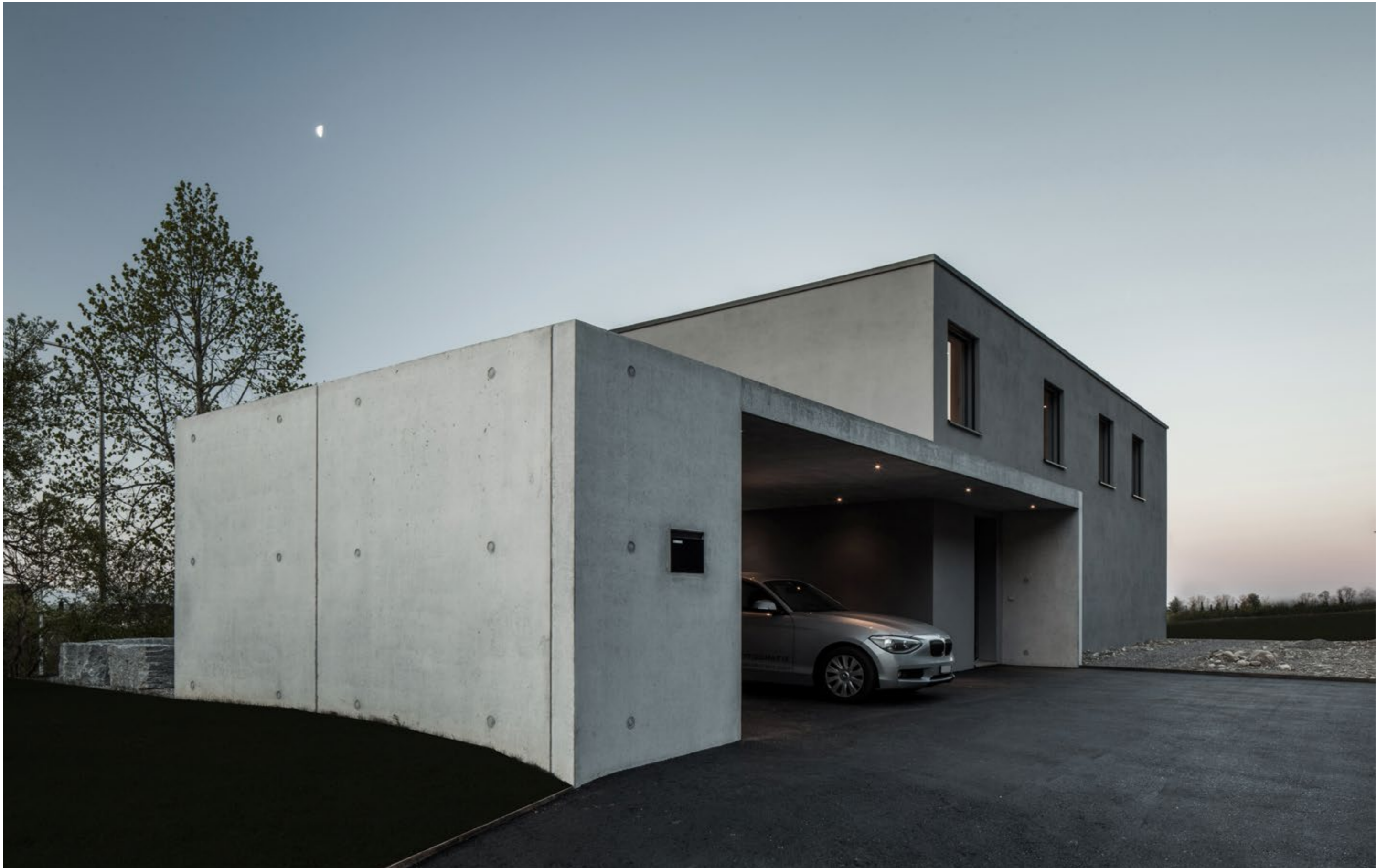
eingangsbereich mit doppelcarport aus sichtbeton mit schalungstruktur
