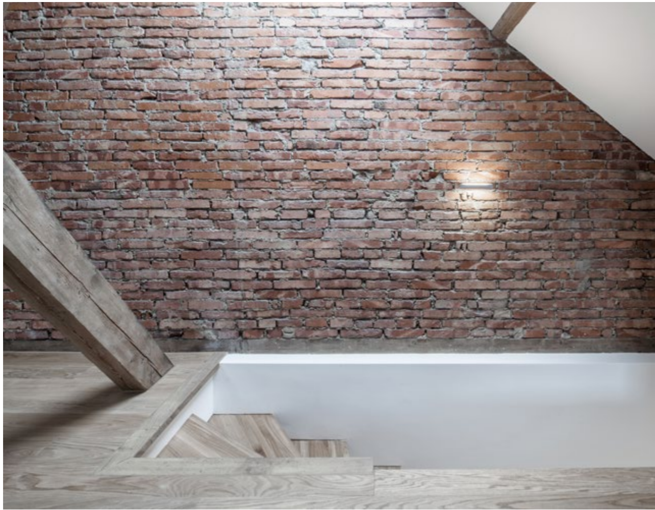
sichtbacksteinmauerwerk unbehandelt mit holztragstruktur
